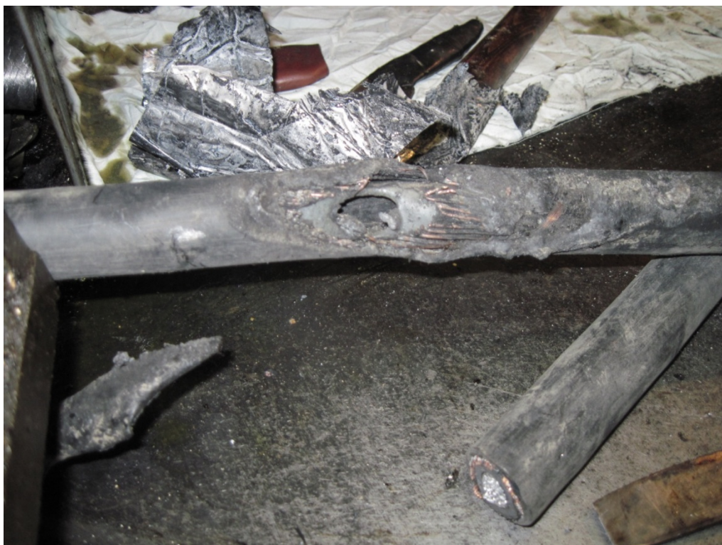
Рис. 2. Последствия однофазного замыкания на землю КЛ с пофазно-экранированными кабелями: ток однофазного замыкания I_c=340 А, время однофазного замыкания t_{033}\approx 2 с
