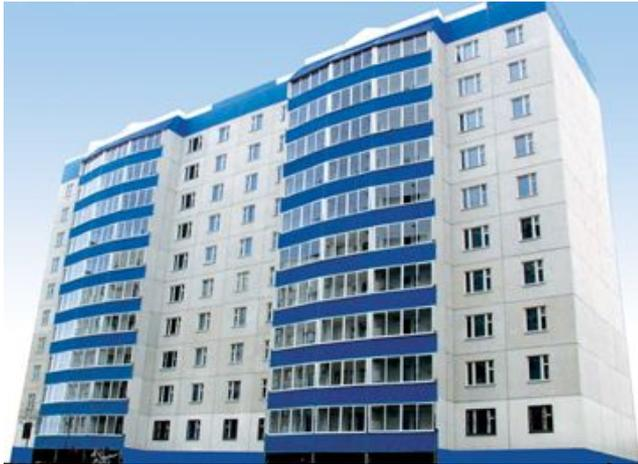
1. Трехслойные панели с утеплителем на гибких связях
