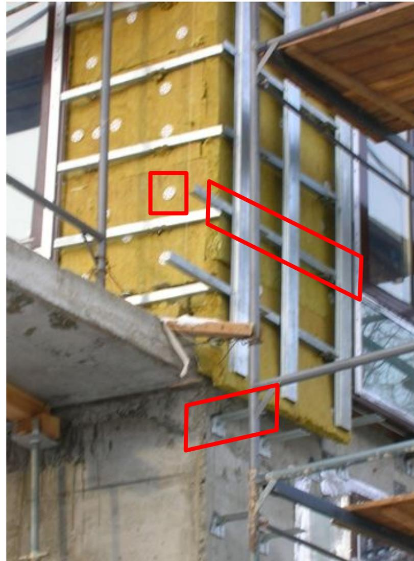
**Расчет основан на представлении фрагмента теплозащитной оболочки здания в виде набора независимых элементов, каждый из которых влияет на тепловые потери через фрагмент**
