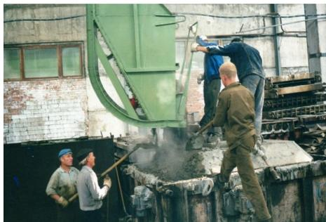
Рисунок 17. Процесс укладки жесткой бетонной смеси в опалубку элемента СОГ.
