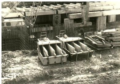
Рисунок 9. Первые экземпляры ЭРУ с электродами толщиной 0,8 мм. на диэлектрических коробах.
