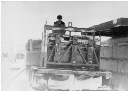
Рисунок 11. Изготовление фундаментных блоков с разогревом смеси в специальном ЭРУ. Пат.2058895
