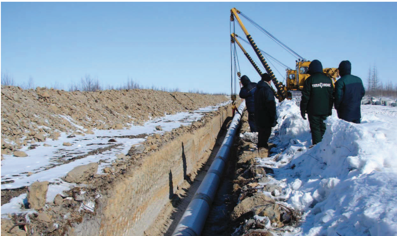
ФОТО 2. Опускание трубопровода в траншею
