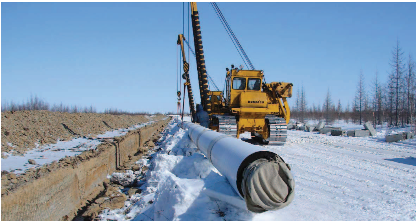
ФОТО 1. Подготовка к опусканию трубопровода в траншею, проложенную в вечномёрзлом грунте
